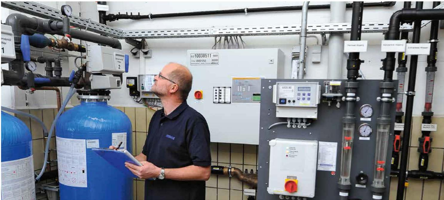
*Die Wasseraufbereitung für die zentrale Kühlwasserversorgung erfolgt im Werk Mühlacker durch eine neue, umweltfreundliche Umkehrosmoseanlage.*
